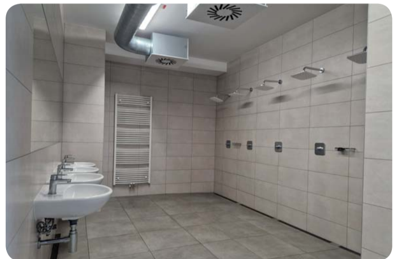
Nové sociální zázemí odpovídá požadavkům 21. století.
